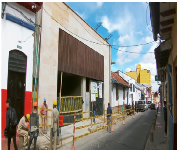
Ilustración 2 Obra de ampliación del ICANH
